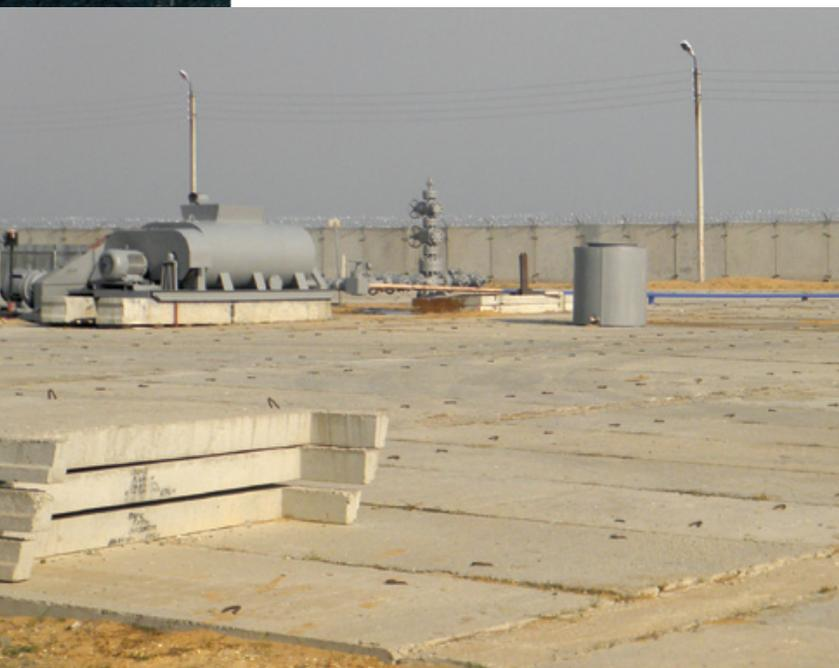
› Серобетон – это композиционный строительный материал, в состав которого входит серное вяжущее, инертные заполнители и наполнители. Спектр применения инертных заполнителей и наполнителей широк. В этом качестве могут использоваться щебень, песок, гравий, металлургические шлаки и прочие породы, применяемые для традиционного бетона.
