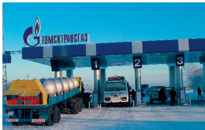
Многотопливная АГНКС в г. Томске после реконструкции
