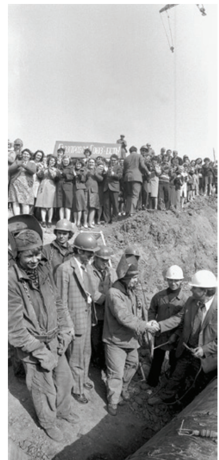
< Сварка Красного стыка, последнего шва магистрального газопровода «Союз» под Ужгородом, осуществленная 12 лучшими сварщиками из Болгарии, Венгрии, Польши, СССР и ЧССР. 1979 г.
