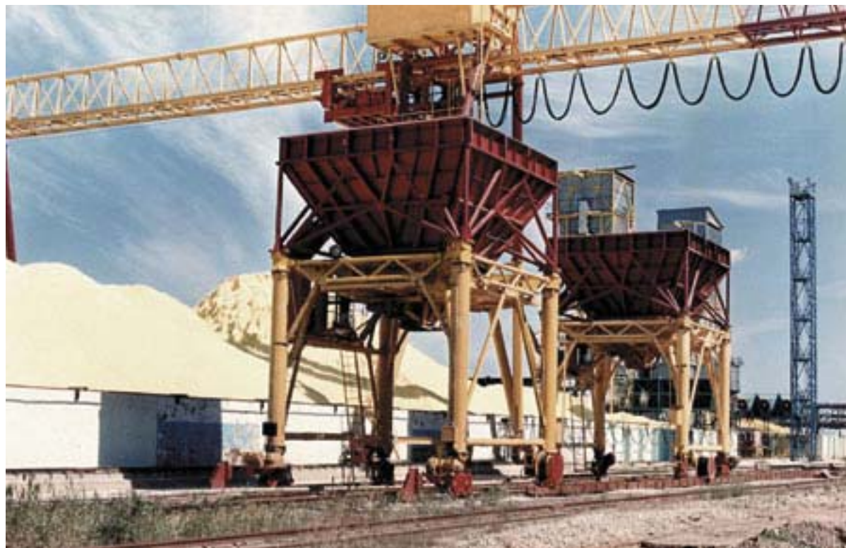
Установка грануляции серы Астраханского газоперерабатывающего завода
