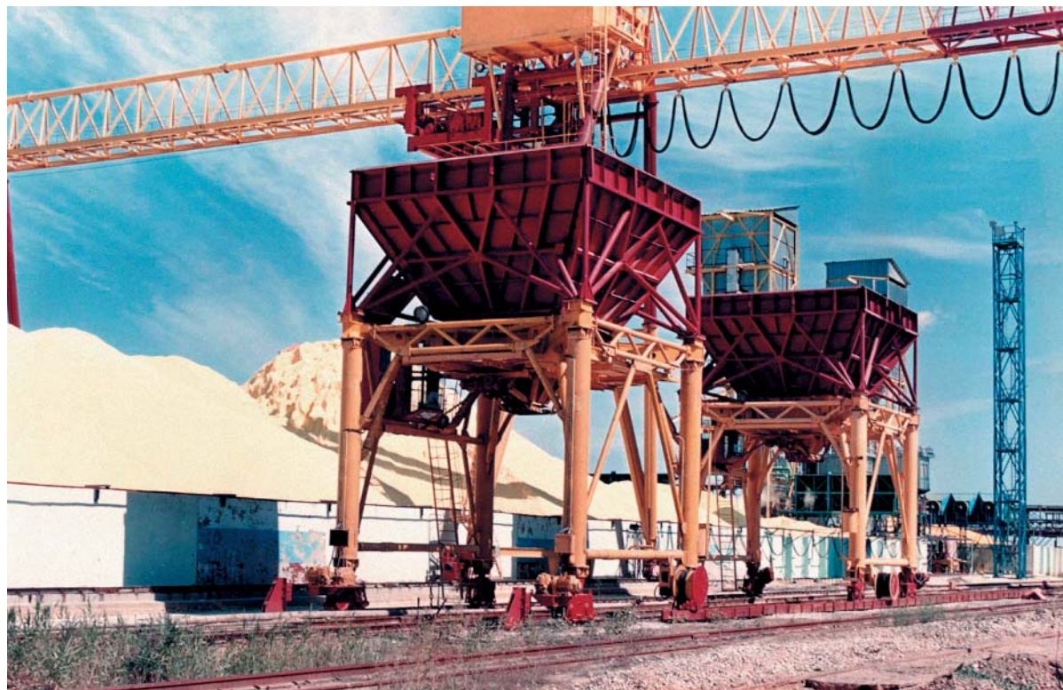
Установка грануляции серы Астраханского газоперерабатывающего завода
