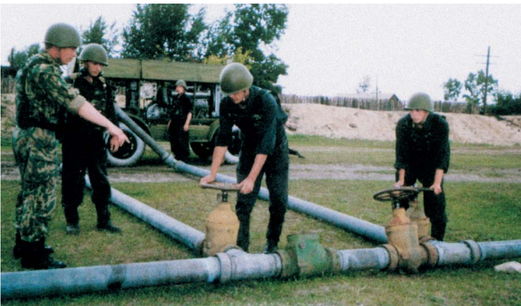
Использование полевого магистрального трубопровода для перекачки воды во время ликвидации последствий взрыва на артиллерийском складе, 2001 г.
