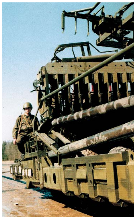
Механизированный монтаж полевого магистрального трубопровода ПМТП-150 трубомонтажной машиной ТУМ-150 В
