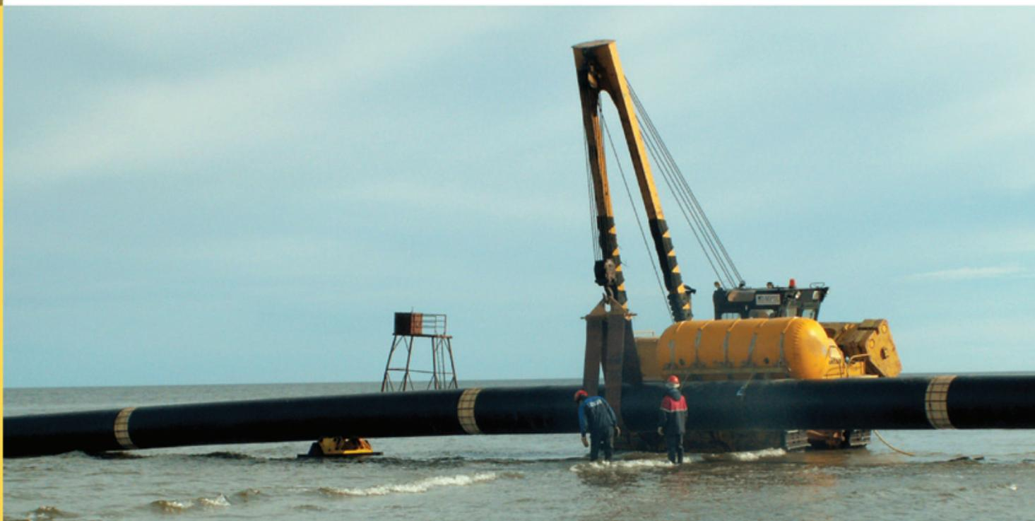
только труба и антикоррозийная изоляция, но и балластное покрытие, которое даже не потрескалось – максимальная глубина повреждений бетона составила всего 14 мм. Между тем вес копра был увеличен по сравнению с требованиями DNV в пять раз.
