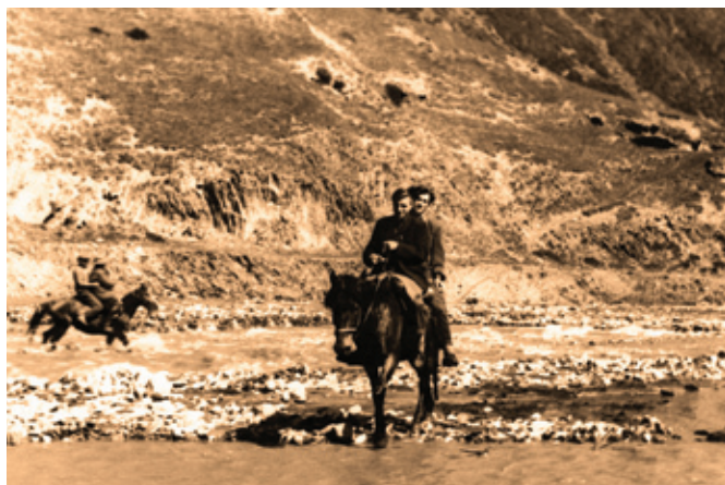
Строительство Закавказского газопровода. 1960 год
