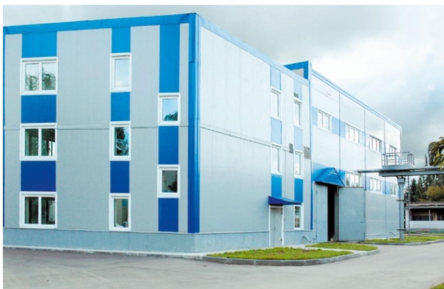
Здание для размещения стендовых установок и лабораторий
