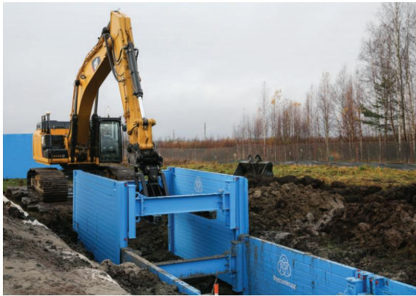
◀ Установка тренчбоксов, поддерживающих стенки траншеи в вертикальном состоянии
