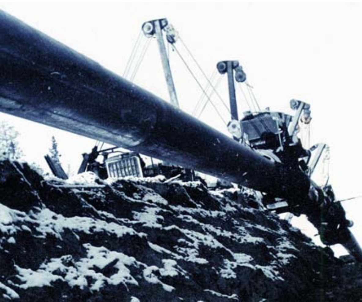
Вуктыл, 70-е годы. Прокладка трубопровода. Фото из архива
