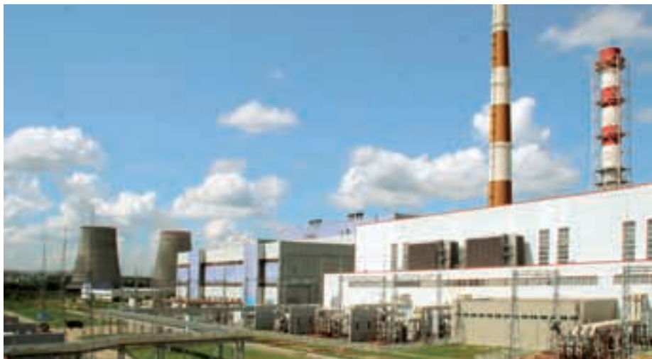
ТЭЦ № 21, ОАО «Мосэнерго»
