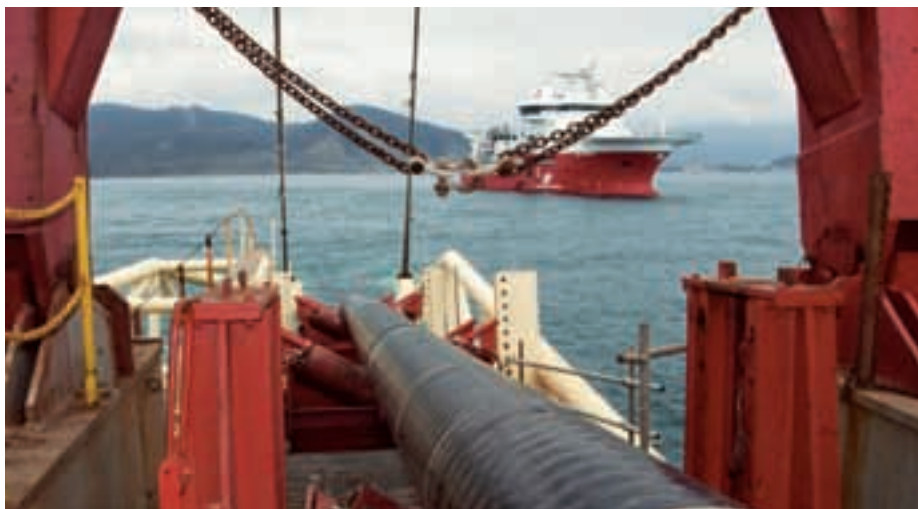
Строительство газопровода «Джубга — Лазаревское — Сочи»
