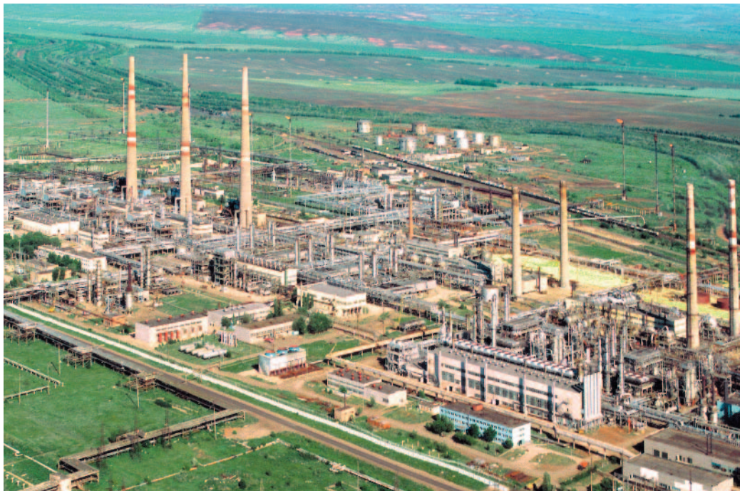
Панорама Оренбургского газоперерабатывающего завода
