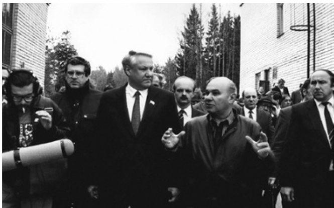
На базе в Петрозаводске. 1991 г.
