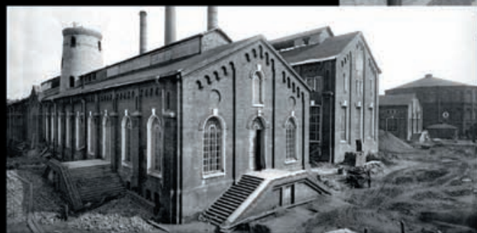
В 1865 году в Москве был построен первый завод по производству светильного газа
