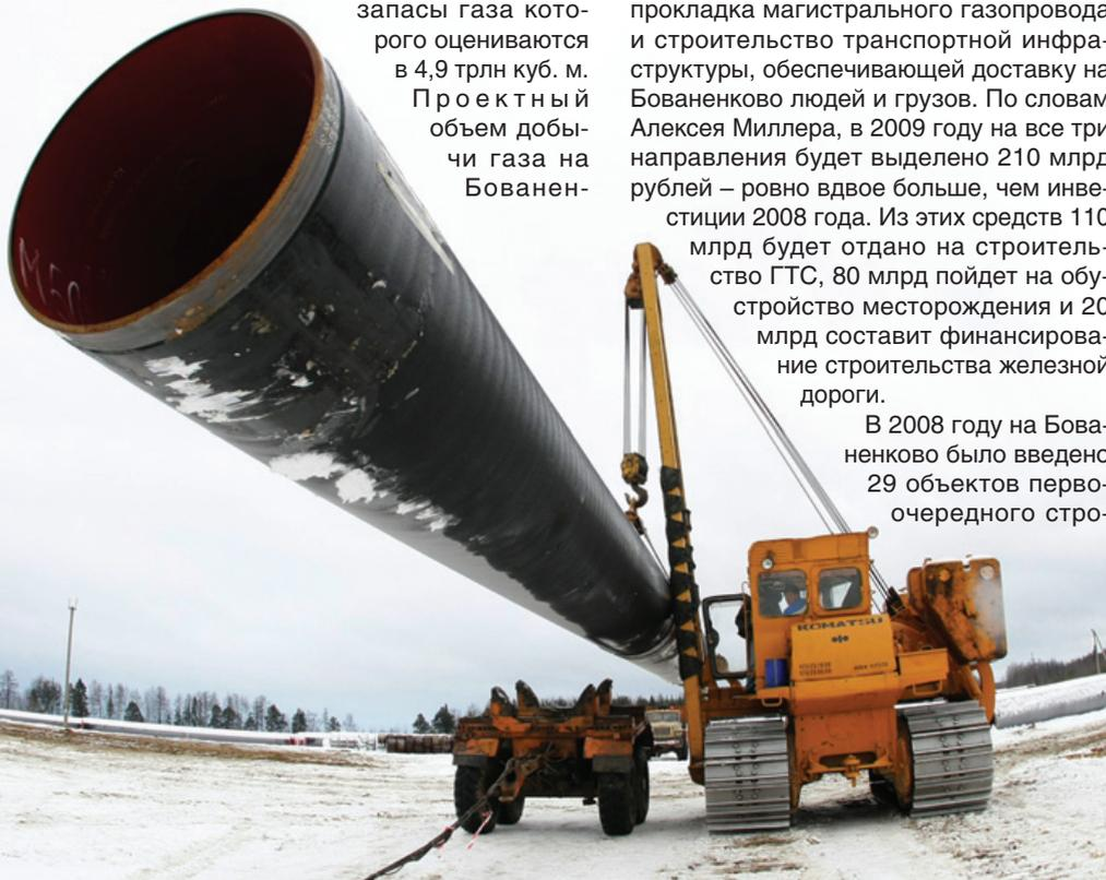
еще не приходилось прокладывать трубопровод в таких условиях. «Газпром» выступил первопроходцем, уложив в период летней навигации этого года около 40 км обетонированных труб. Через три года будут построены первые две нитки подводного перехода протяженностью 72 км каждая.
