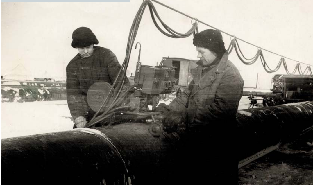
Строительство второй очереди газопровода «Ставрополь – Москва»
