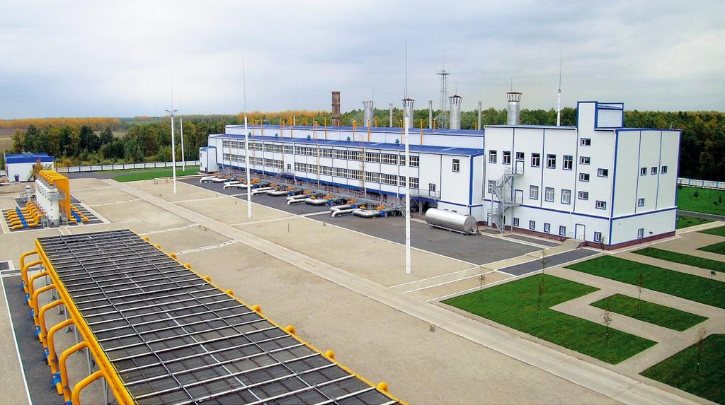
му, что раньше в цехе работало 8 ГПА, а теперь их стало лишь 5. Причем длина используемых производственных площадей сократилась на 90 м, что значительно снизило затраты на их содержание. В то же время удельный расход «топливного» газа уменьшился почти на 20%, а пускового – более чем в 10 раз.
